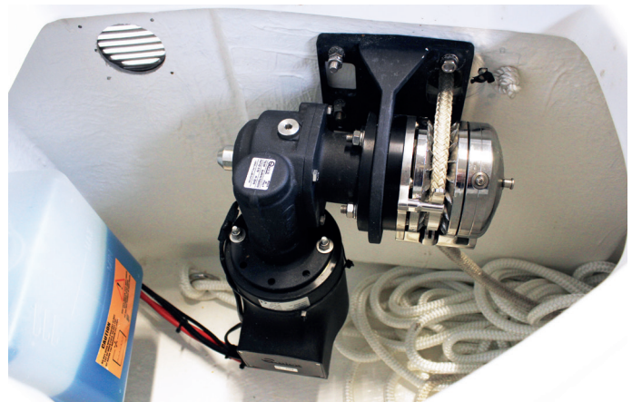
Akterspeilmontering sett fra innsiden.
