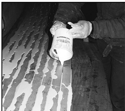
Mellomrommene mellom trestavene fylles med West System epoxy, bruk sprøyte, sparkel eller blandebeholder med «tut». West System Norge leverer tompatrøner med stempel og spiss.
